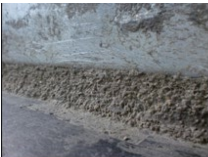
Verfüllter Zwischenraum mit TerraFill-M
