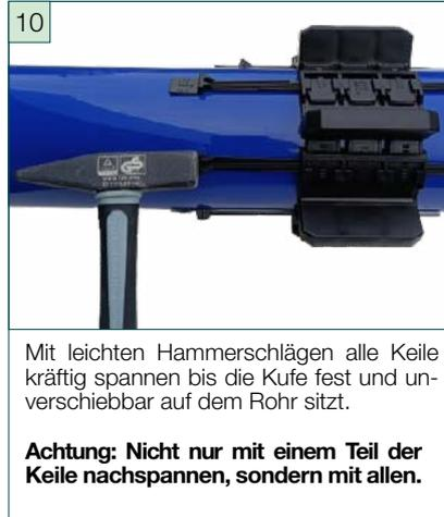
Mit leichten Hammerschlägen alle Keile kräftig spannen bis die Kufe fest und unverschiebbar auf dem Rohr sitzt.
